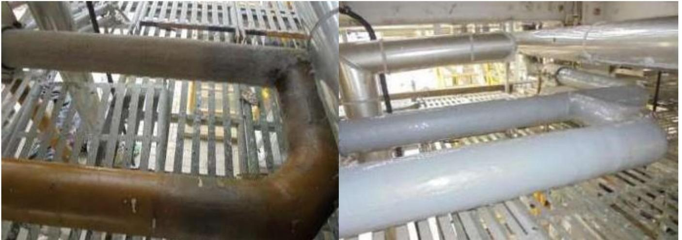
Les revêtements composites d'isolation liquides Resimac sont basés sur une combinaison de charges innovantes liées dans une résine époxy 100% solide.
