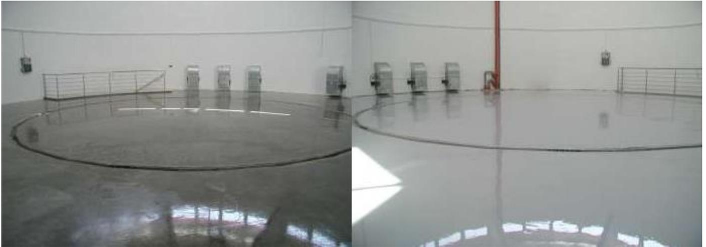
Les revêtements de sol Resimac sont une gamme de systèmes à base de résine époxy sans solvant, idéaux pour le surfacage et la reconstruction de surfaces en béton.
