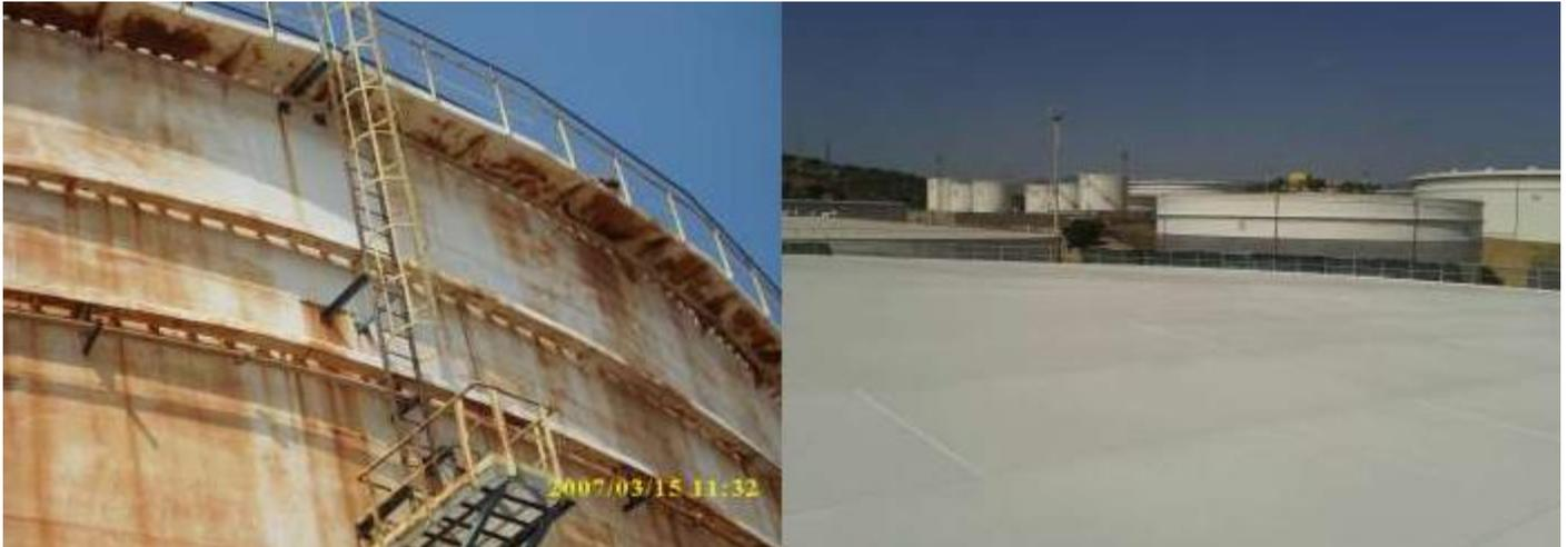
Les produits Resimac de protection contre la corrosion sont basés sur des systèmes de résine acrylique, époxy et polyuréthane.
